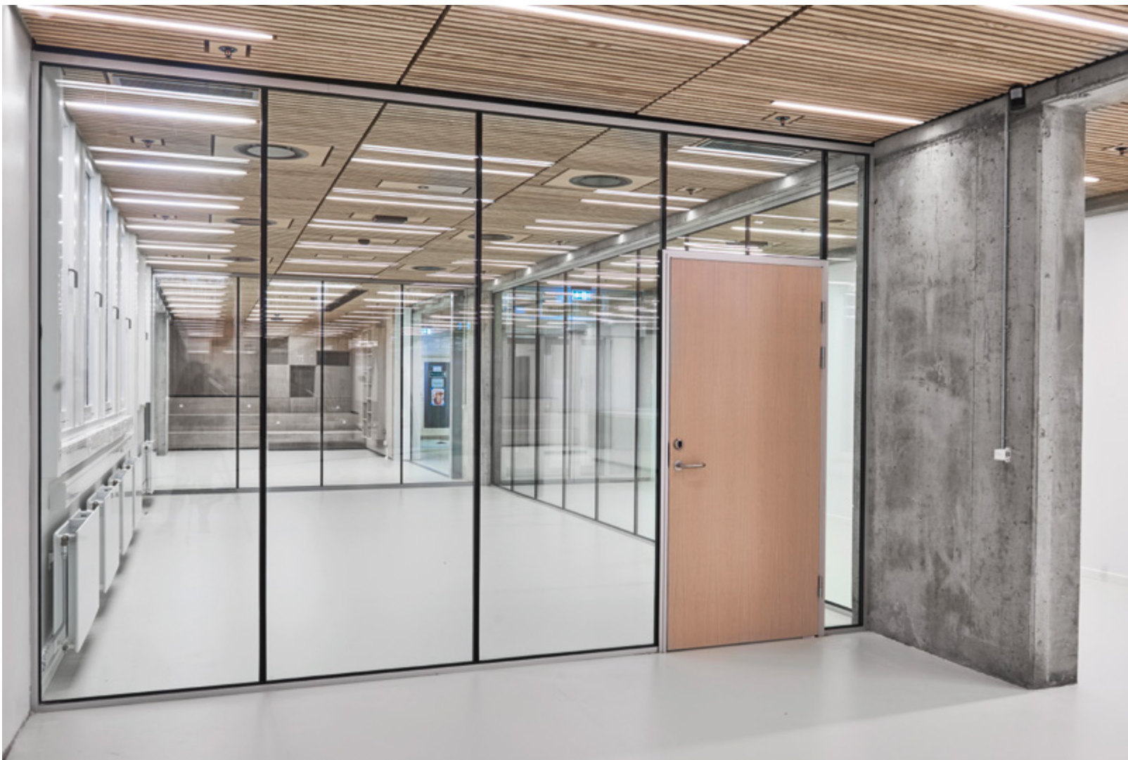
Ombygning Udenrigsministeriet, København
